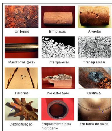
Formas de corrosão
